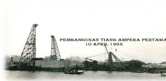
Gambar 2. Foto pembangunan tiang pancang jembatan Ampera (Sumber: foto koleksi Komunitas Pecinta Barang Antik Sriwijaya Palembang)
